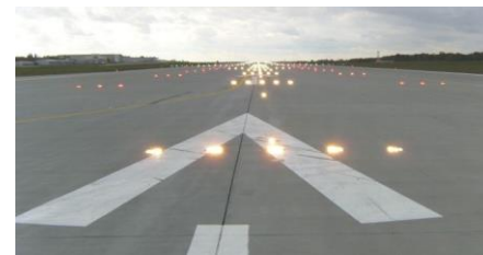
Flughafen Berlin-Schönefeld, Sanierung S/L-Bahn Nord (u.a. 220.000 m 2 Herstellung Antiskid-Belag)
