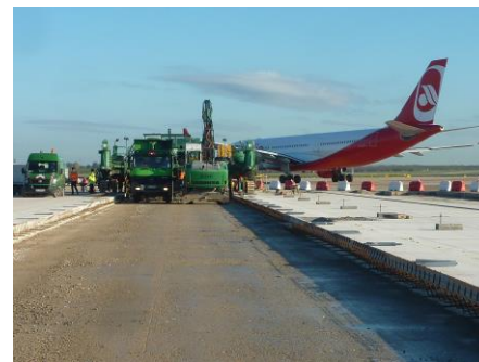
Flughafen Düsseldorf, Sanierung TWY L7
