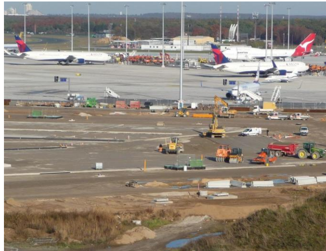
Flughafen Frankfurt/Main – Ramps 4 + 5 Erdmassen ca. 180.000 m 3 , Beton-/Asphaltflächen ca. 188.000 m 2
