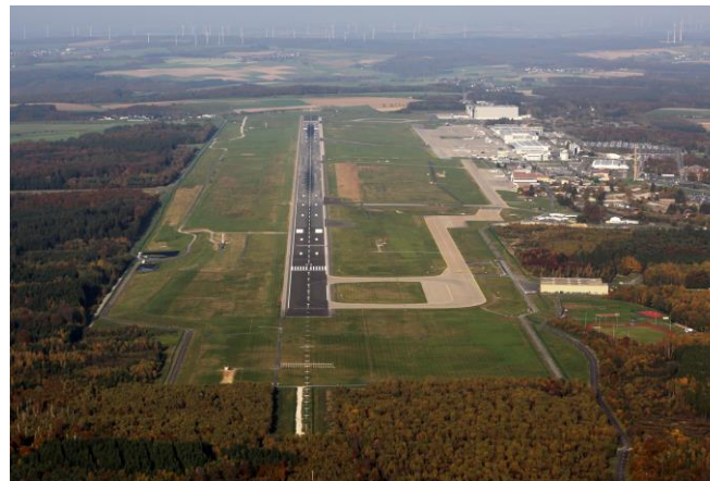
Komplettausbau Flughafen Frankfurt-Hahn mit u.a. umfangreichen Geländeregulierungsmaßnahmen, Beton-/ Asphaltflächen: ca. 65.500 m 2 , S/L-Bahn-Verlängerung, Rollbahn-/Entwässerungssysteme, versetzter Schwelle 03, Speicherbecken für Enteisungsmittelhaltiges Wasser (44.000 m 3 ) (© Bild: PlanePictures.net, Reiner Bexten für Flughafen Frankfurt-Hahn GmbH)
